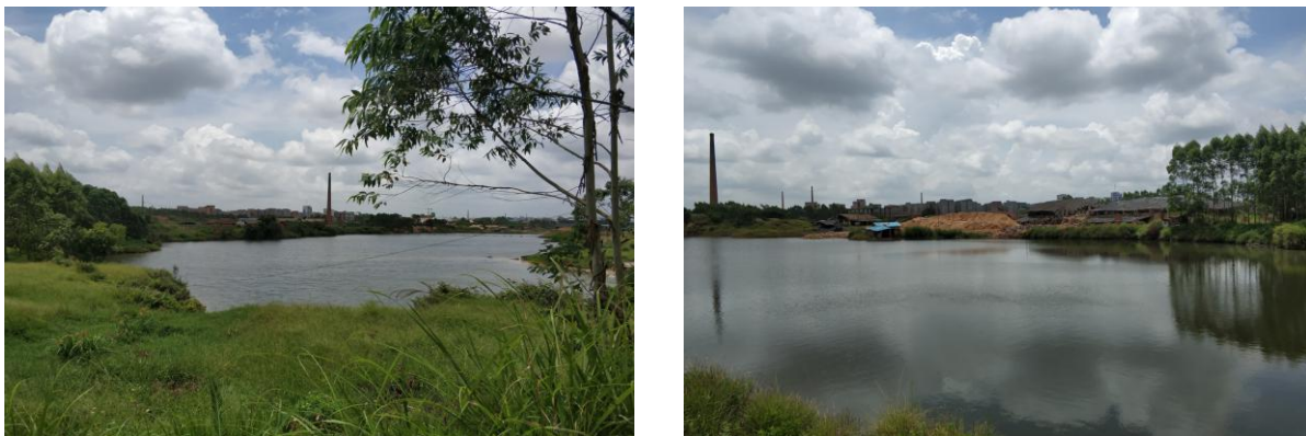
图 2.1-1 备选场址 1 现状
